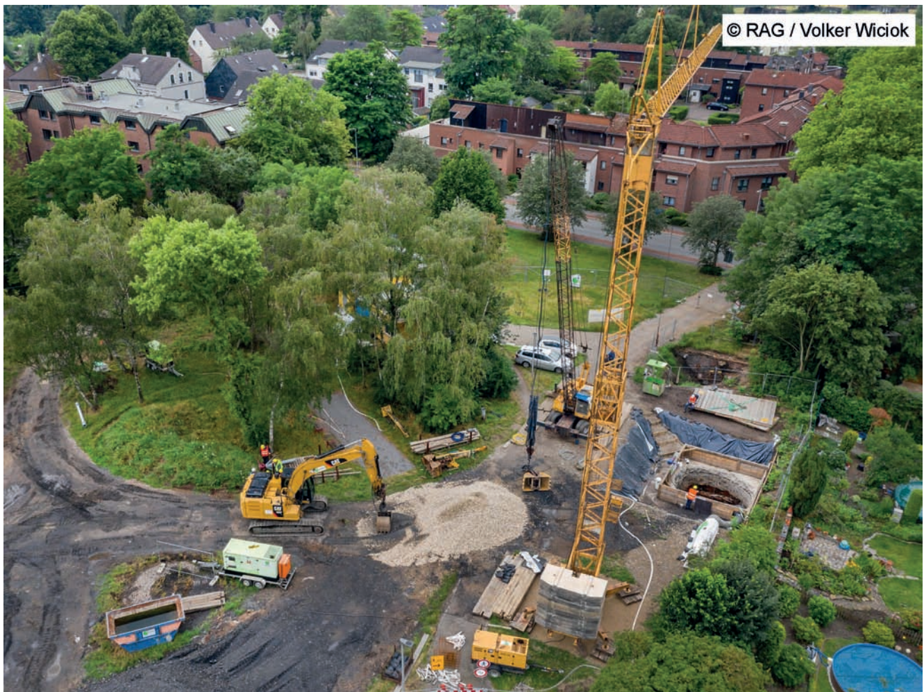
Abb. 2: Schachtkopfsanierung der RAG am Tiefbauschacht Alstaden 2 im Stadtgebiet Oberhausen.
